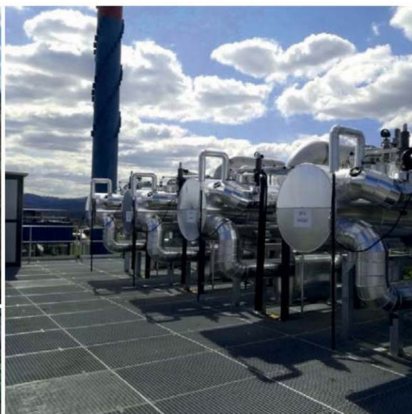
In der Steiermark werden mit Abwärme aus Produktionsbetrieben und einer Abwasserreinigungsanlage die regionalen Wärmenetze gespeist – so in Leibnitz (Bilder oben) und Gleisdorf (links unten).
